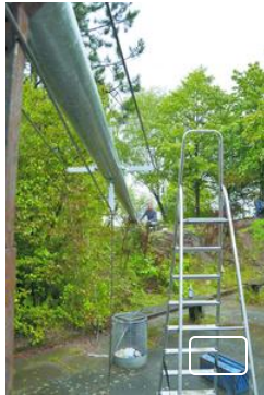
Beim Aufbau des Windrades mussten einige Unwegsamkeiten beseitigt werden
